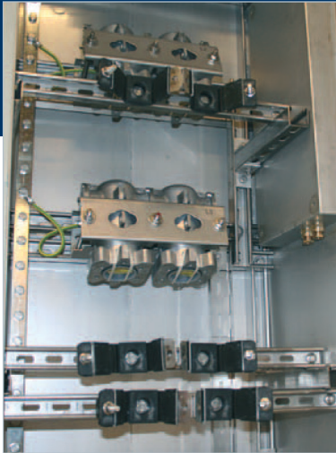
Ex nR solution for 11kV 3x240mm 2
